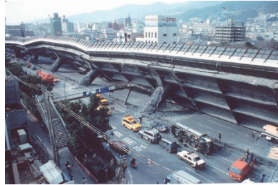
阪神・淡路大震災で倒壊した高速道路
