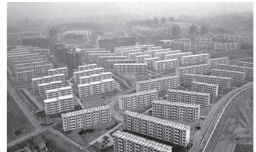
大都市の郊外につくられた団地
