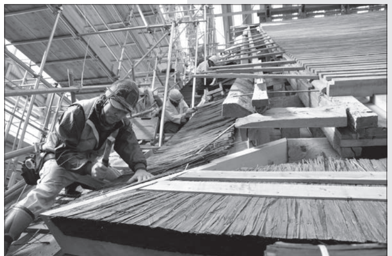
▲檜皮葺(ひのきの皮を薄くはいだものを重ねて葺く)の技法で屋根の葺き替えをする職人。
