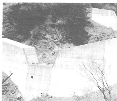
図3 砂防ダムの高さは約10 m
