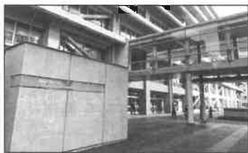
①内閣の出先機関が多く入る 福岡合同庁舎
