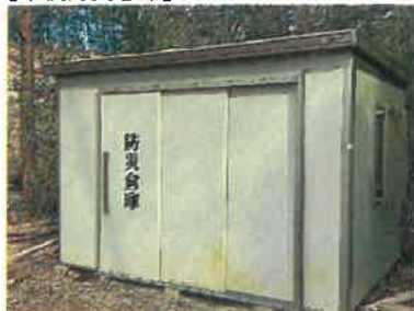
【本校防災倉庫】
