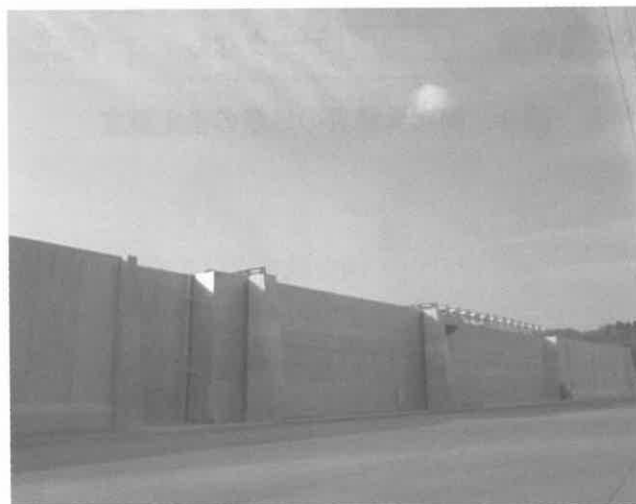
図 2 宮古港海岸の防潮堤
