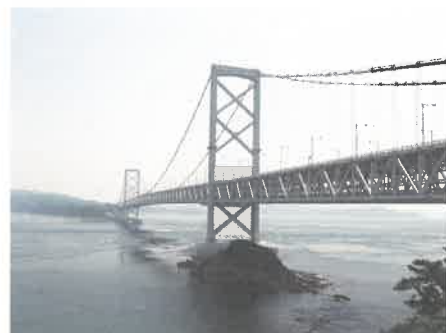
【写真1 大鳴門橋】
