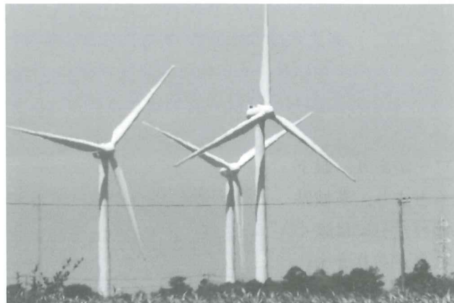
写真3 風力発電施設
