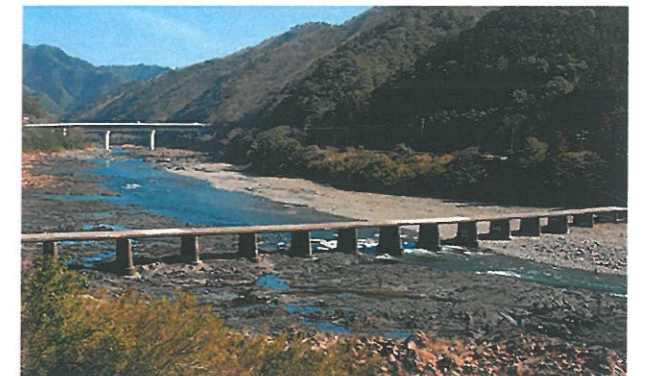
写真2：高知県四万十市 半家沈下橋 (手前)
