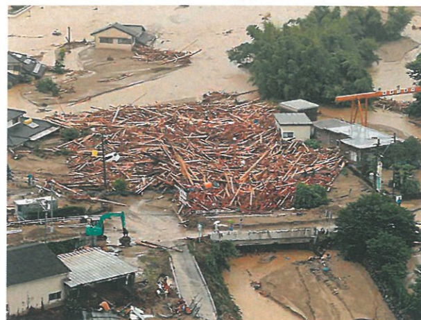
写真5：平成29年北九州豪雨福岡県朝倉市
